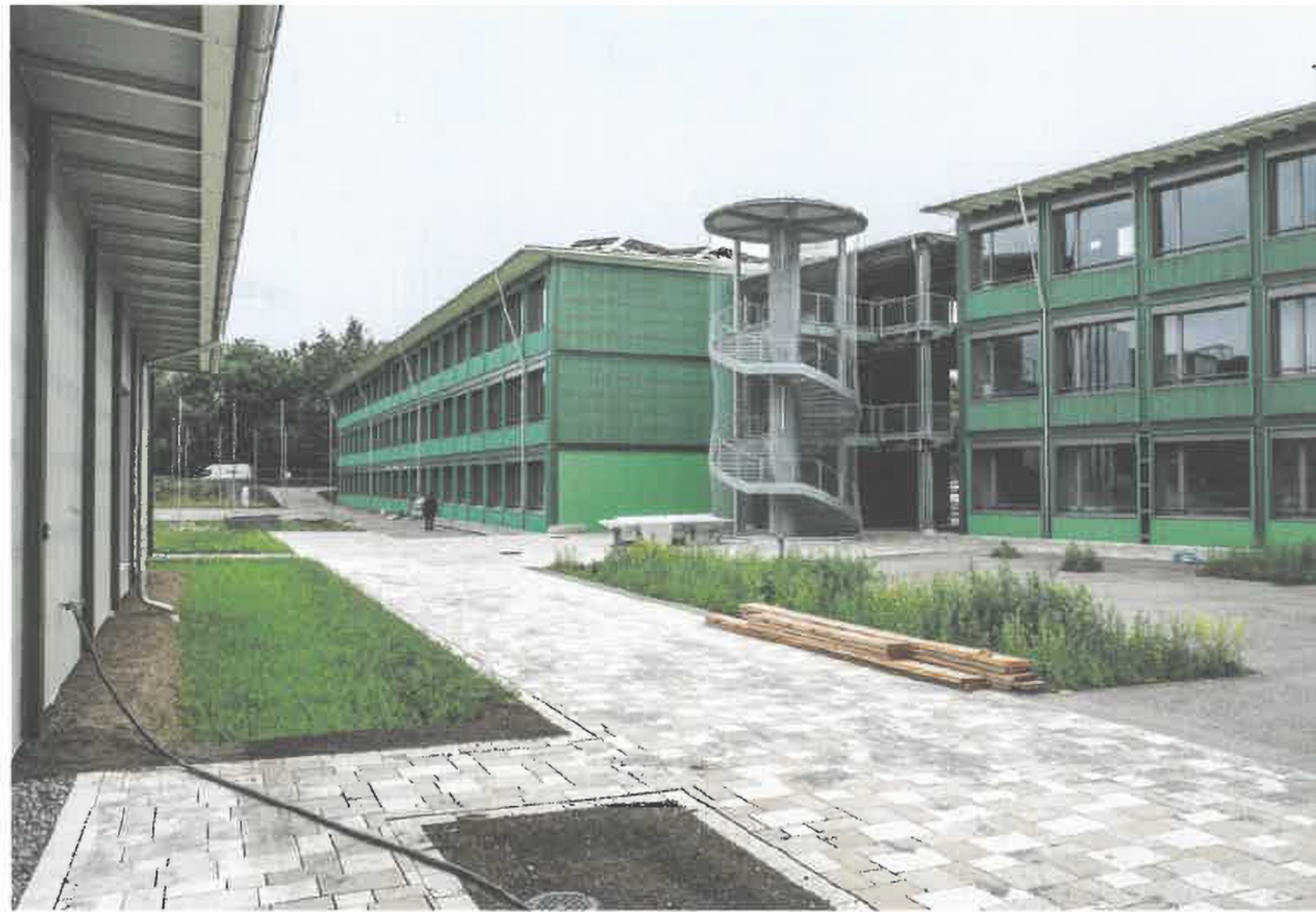
Die vorgefertigten Module können in Dübendorf demontiert und andernorts wieder aufgebaut werden.
