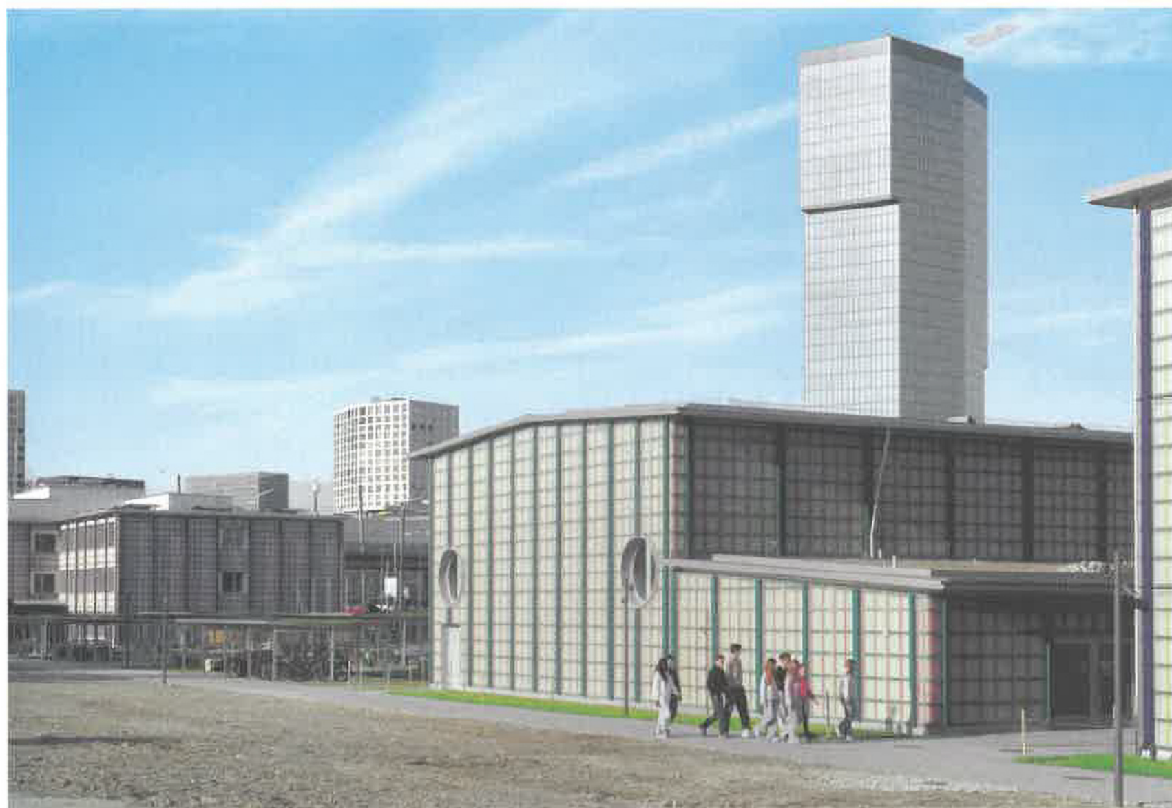
Die temporären Bauten an der Hohlstrasse in Zürich sind in einem Bausystem erstellt, das im ganzen Kanton zum Einsatz kam. Foto: Peter Tillessen
