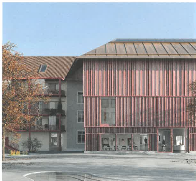
Anbau als moderner Holzbau mit Kupferdach
