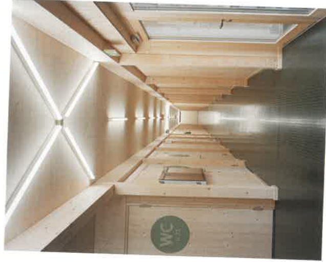
Die Klassentrakte bestehen aus hölzernen Raummodulen. Je drei Module bilden ein Schulzimmer mit zugehörigem Korridoranteil. Bilder: Peter Tillessen
