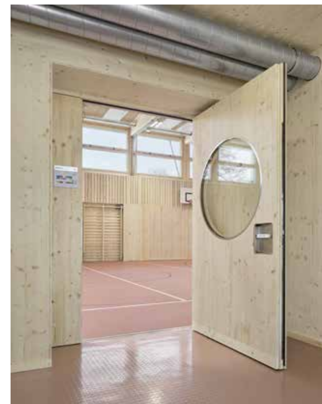
Die Elemente der Sporthallen sind flächenbündig und reversibel verschraubt.
