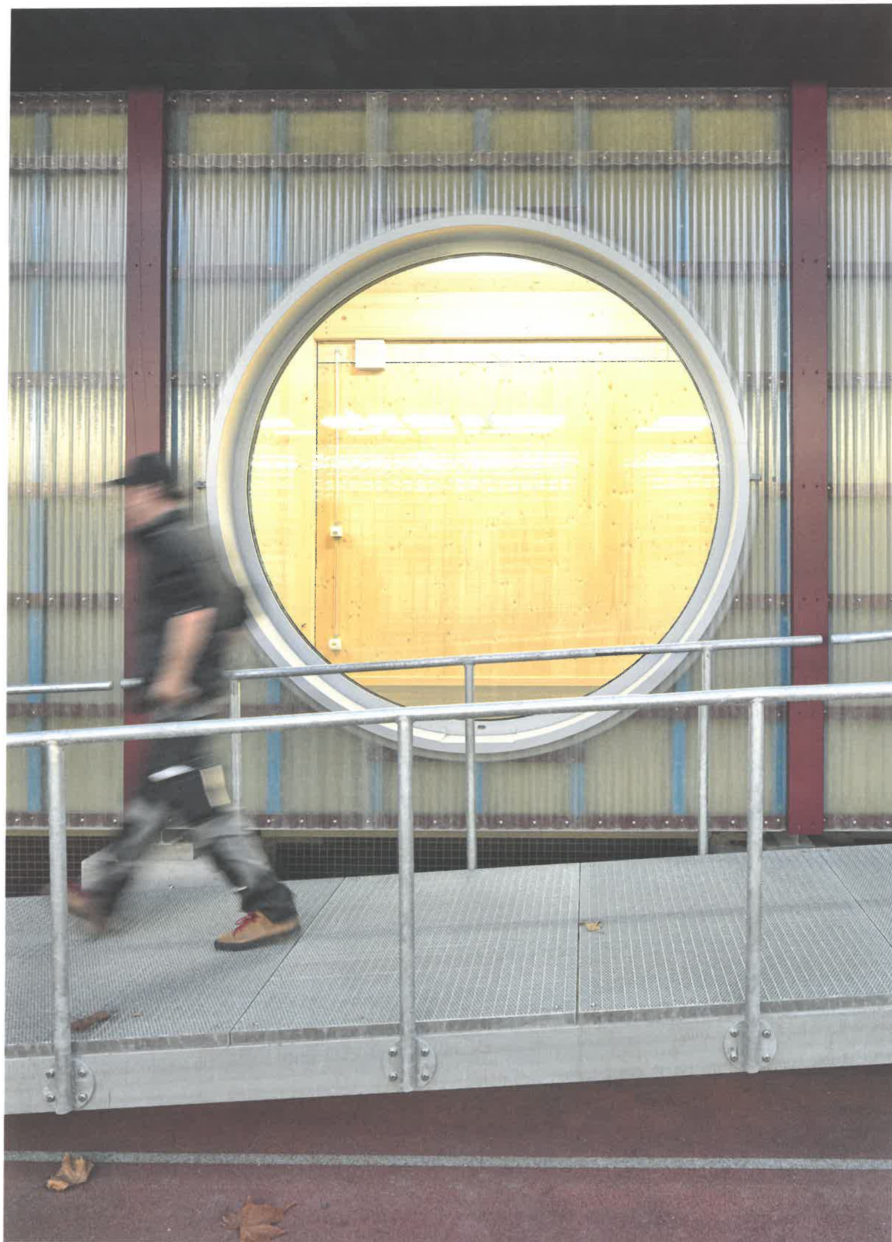
Die Fassade aus Kunstharzplatten und Holz lässt sich an den Kontext anpassen.
