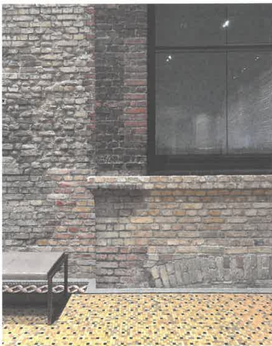
Ergänzungen durch wiedergewonnene Ziegel bei der Rekonstruktion der Wände, Neues Museum Berlin
