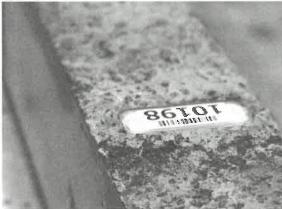
Circle House, Fertigteil mit Barcode
