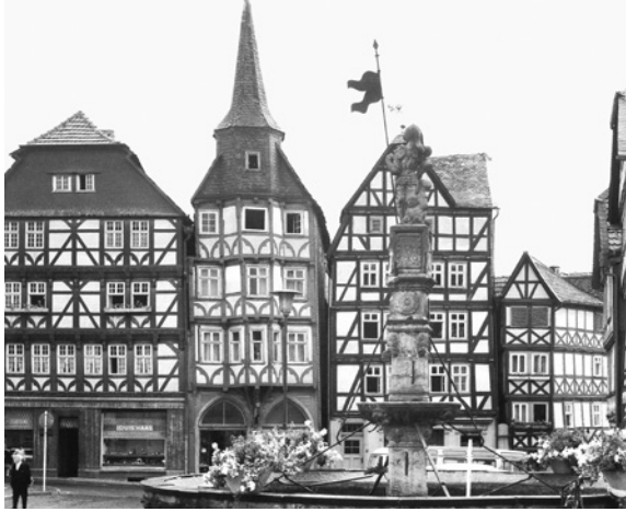
ABB. 1 Das Fachwerk bindet die Bauten visuell zusammen, gleichzeitig bestimmt die konstruktive Logik Gliederung und Ausdruck der Fassade.
