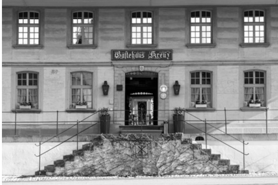
Abb. 6 Gasthaus Kreuz in Dürrenroth, Emmental, circa 1806. Die Fassade aus massiven Holzbrettern erhält durch ihre Bemalung eine steinerne Anmutung.
