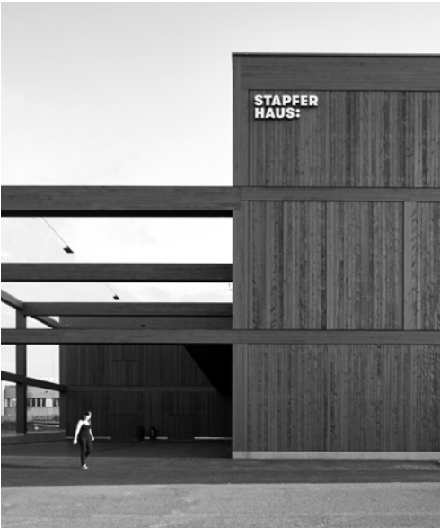
Abb. 7 Stapferhaus, Lenzburg 2018, pool Architekten.
