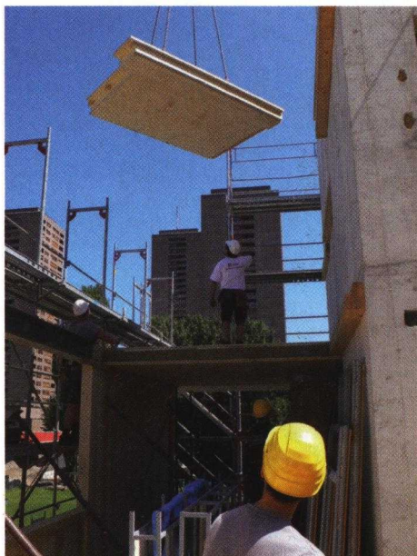
△ Montage d'un mur élément par élément. < Installation d'un plancher. V À gauche : pose du revêtement de façade en béton fibré extrudé. À droite : une structure dédiée reçoit les fluides pour la cuisine. V La même cuisine, une fois aménagée, avant livraison.
