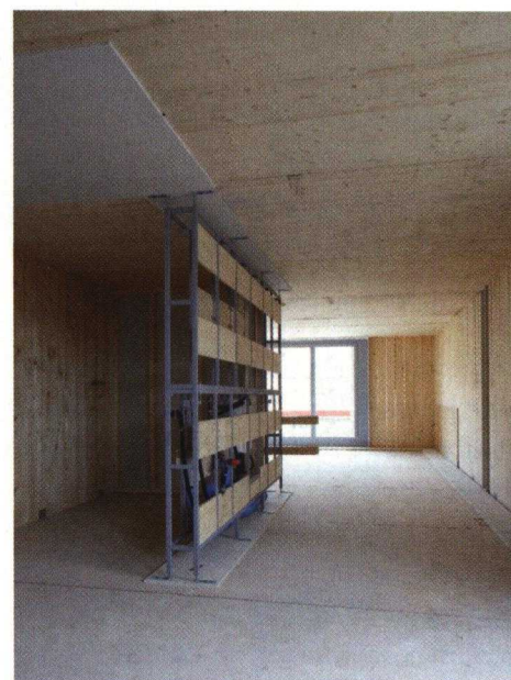
△ Montage d'un mur élément par élément. < Installation d'un plancher. V À gauche : pose du revêtement de façade en béton fibré extrudé. À droite : une structure dédiée reçoit les fluides pour la cuisine. V La même cuisine, une fois aménagée, avant livraison.
