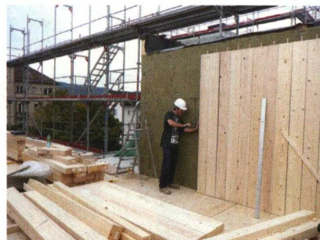
△ Montage d'un mur élément par élément. < Installation d'un plancher. V À gauche : pose du revêtement de façade en béton fibré extrudé. À droite : une structure dédiée reçoit les fluides pour la cuisine. V La même cuisine, une fois aménagée, avant livraison.
