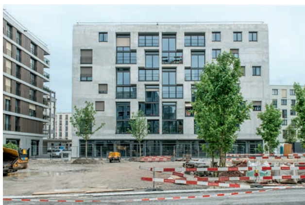
Das Haus besteht aus monolithischem Dämmbeton.
