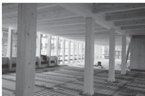
^ ... zusammen mit der vor Ort gegossenen Holz-Beton-Verbunddecke.
