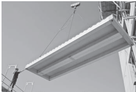
✓ Ein Deckenelement wird angeliefert ...
