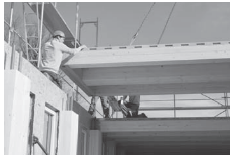
✓ ... und in fünf Minuten verlegt.
