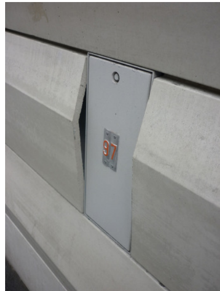
Detail Fassade, Foto: Redlich
