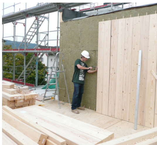
Montagefortschritt, Foto: pool Architekten
