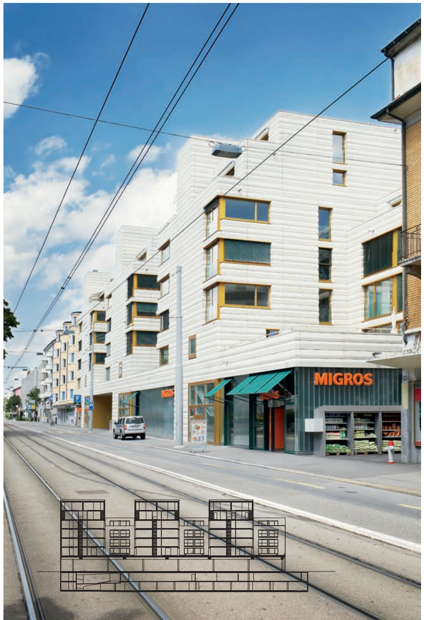
Badenerstrasse, ZH: Wettbewerb 1. Preis, Ausführung 2008- 2010. Das Wohn- und Geschäftshaus ist im Rahmen des Pro- gramms „Bauen für die 2000-Watt-Gesell- schaft“ entstanden. Zur Strasse öffnen sich die Verkaufsflächen, die in einem Betonsockel untergebracht sind. Da- rüber verteilen sich die Wohnungen ins sechs Baukörper.
