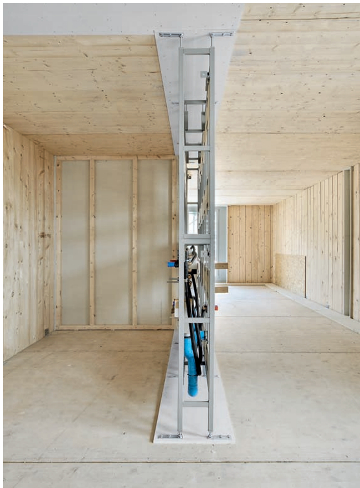
Blick in den Rohbau: Dem fertigen Gebäude sieht man nicht an, dass die Wohngeschosse in Holzbauweise erstellt worden sind.
