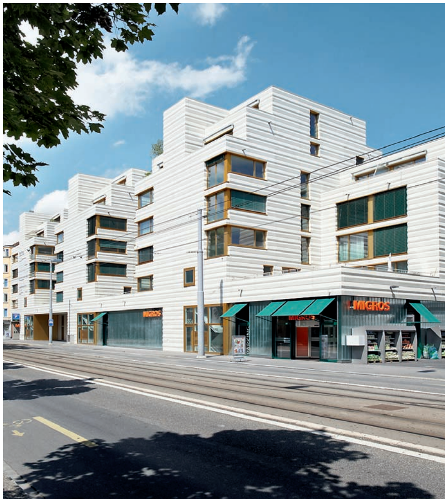
Urbane Lage: An der – normalerweise stark befahrenen – Badenerstrasse kann es laut werden. Dank der versetzten Baukörper ist trotzdem eine natürliche Belüftung möglich.
