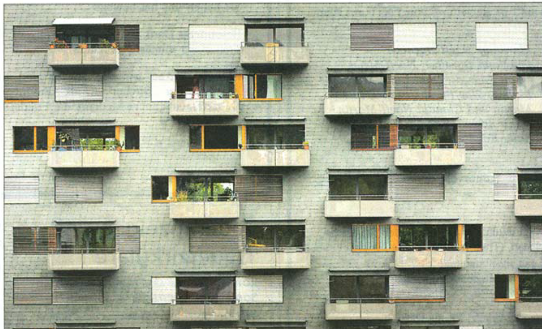
Versetzt angeordnete Balkone nehmen der Fassade jegliche Monotonie.
