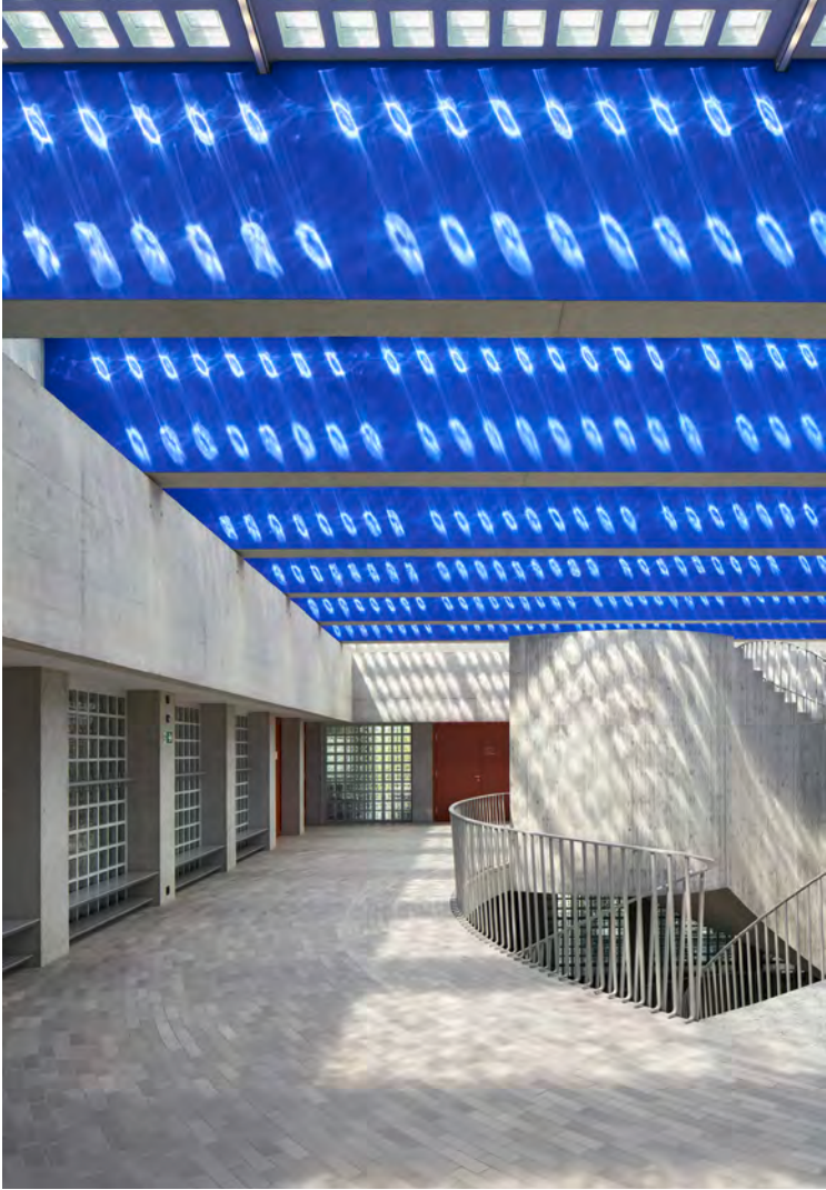
Zwischen den vorfabrizierten Betonträgern sind Glasbausteinelemente feldweise eingebaut, dazwischen befindet sich die Beleuchtung
