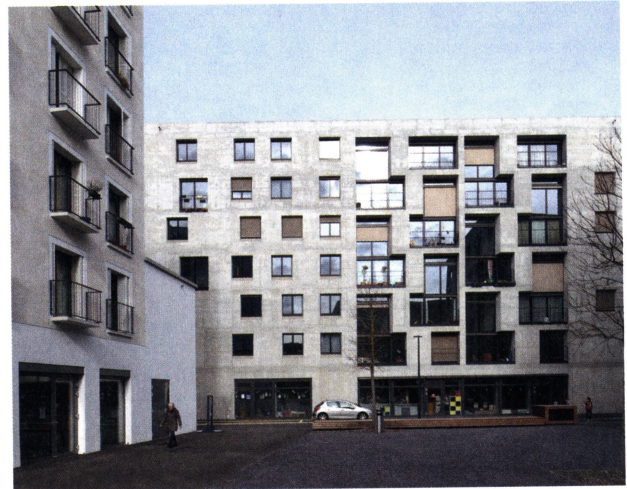
Haus G: Ansicht von Süden. Im Bereich der L-förmigen Loggien sind die Außenwände aus Dämmbeton bis zu 80 cm stark.
